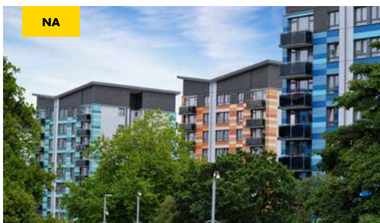
RENOVATIE CHARLEMONT FARM RESIDENTIE, VERENIGD KONINKRIJK.
